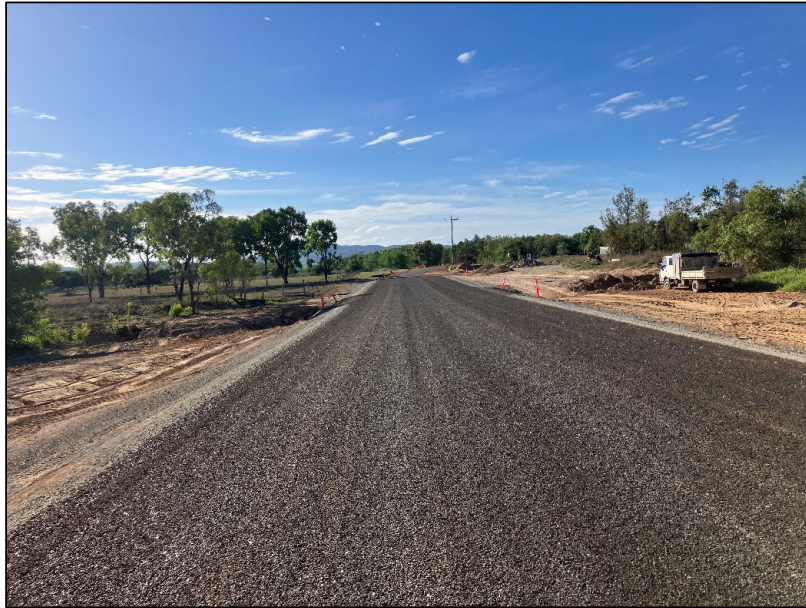
2-Coat bitumen seal
