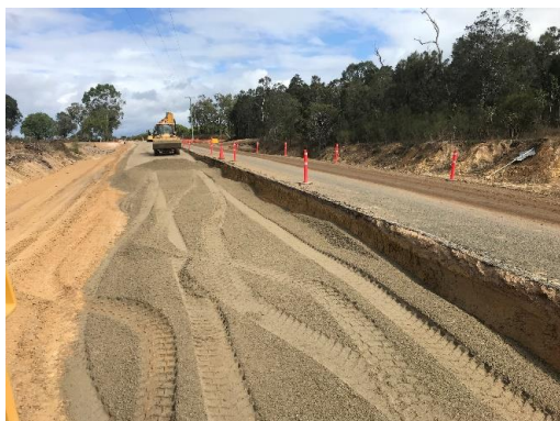
RHS subbase layer
