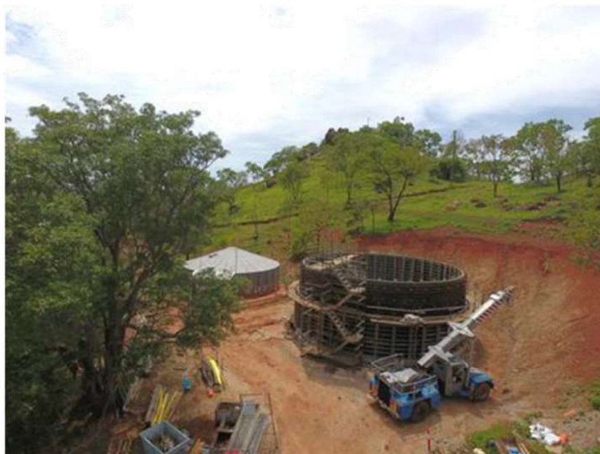
Second reservoir wall concrete pour
