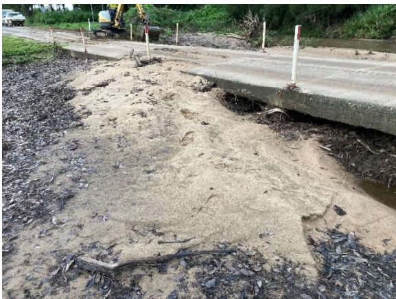
Inlet/Outlet Clearing Ada Creek
