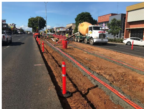
Electrical Conduit Protection
