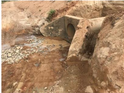
Sunken Culvert
