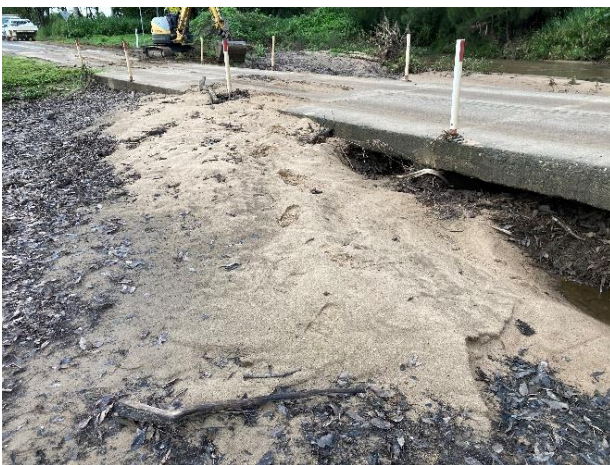
Inlet/Outlet Clearing Ada Creek
