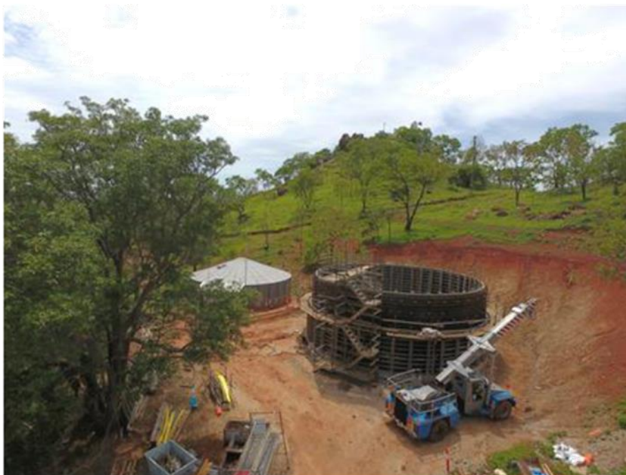
Second reservoir wall concrete pour
