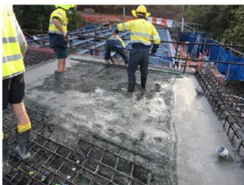
Pouring Span 2
