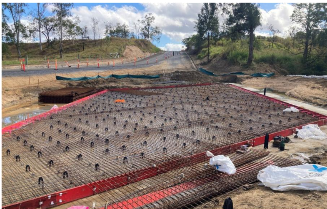
Ada Creek Causeway Base Slab Steel Pre-Concrete Pour
