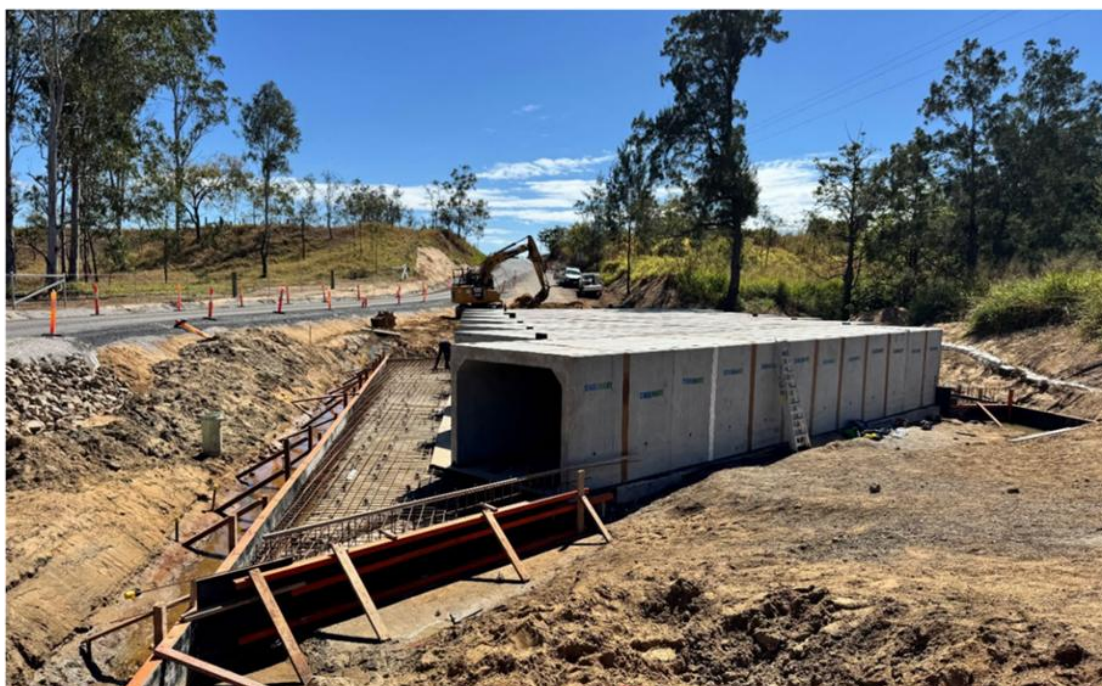
Ada Creek Aprons Pre-Concrete Pour
