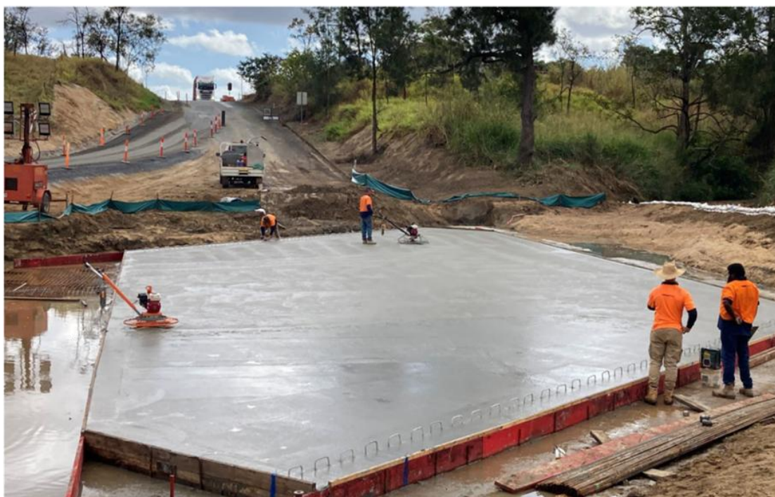
Ada Creek Base Slab Pour 1 st July
