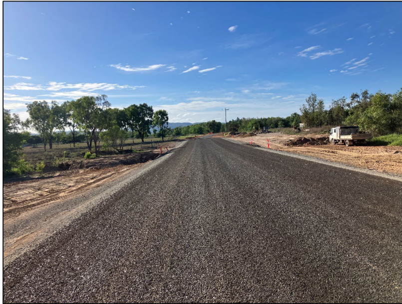
2-Coat bitumen seal
