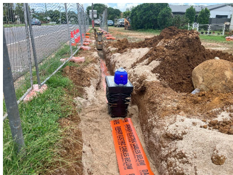
Conduit installation
