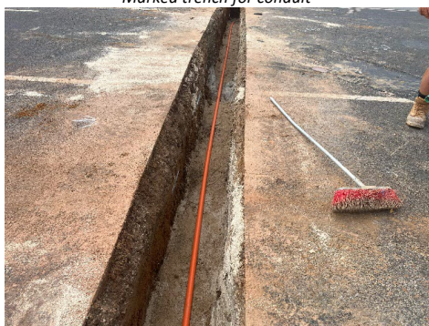
Installed conduit
