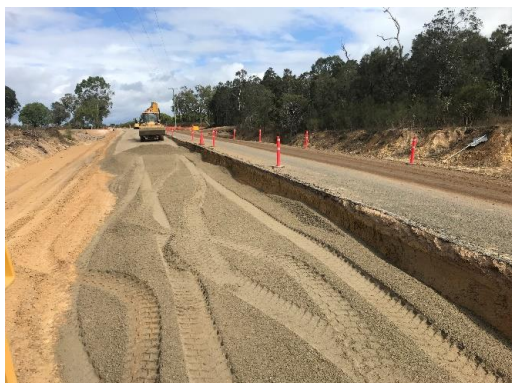
RHS subbase layer
