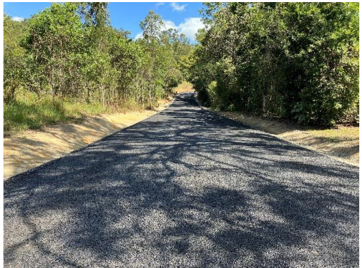
Completed 2 coat seal (D)
