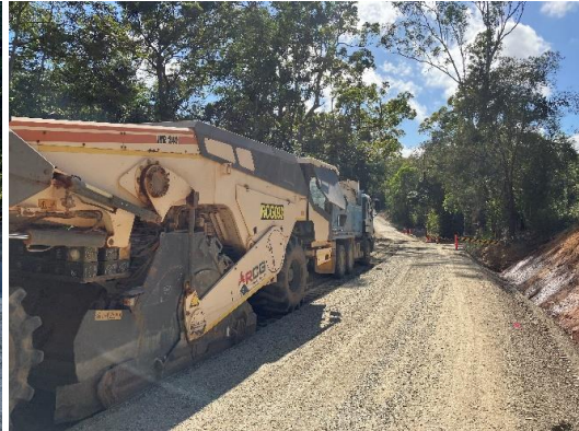
Stabilising base layer (D)
