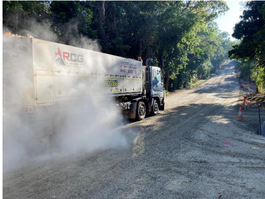
Spreading cement powder prior to stabilising (D)
